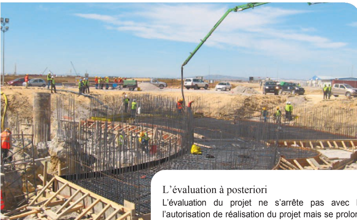
Chantier de construction de l'aéroport d'Enfidha
