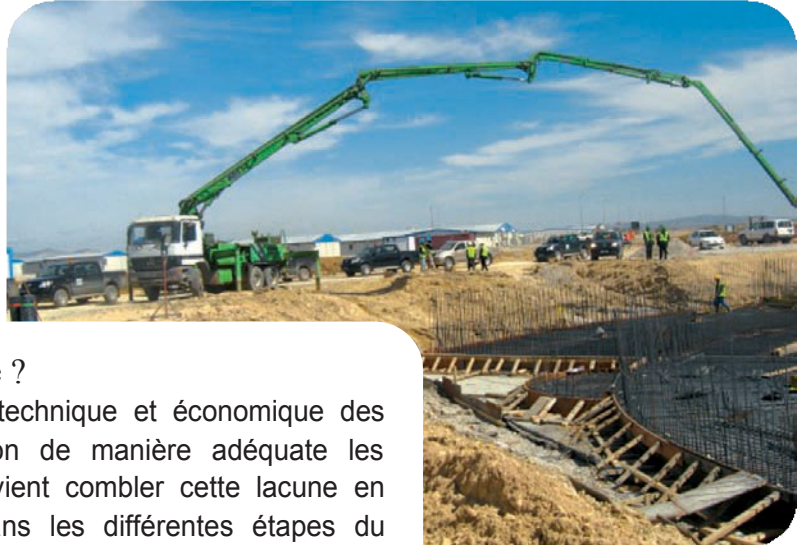
Chantier de construction de l'aéroport d'Enfidha
